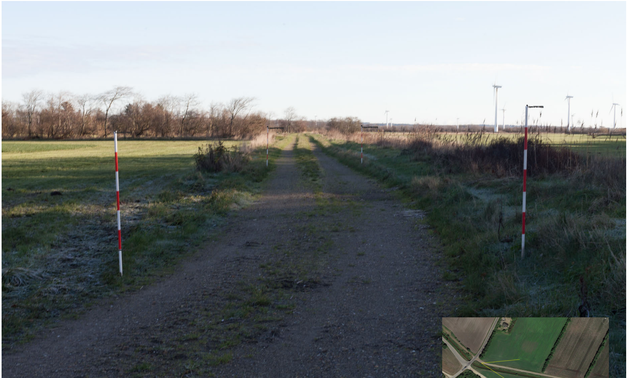
Eksisterende forhold Fotopunkt 1
